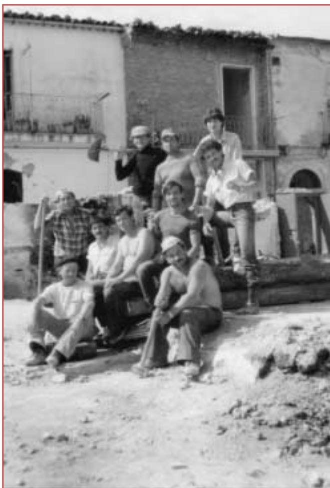
Calitri, fine maggio 1981. Un gruppo di operai al lavoro durante la demolizione del Borgo Castello. Prima fila da sinistra in piedi: Domenico Lombardi ( m'ngucc' ), Michele Fierravanti ( halecchia ), Vincenzo Del Moro ( p'ccion' ) e Antonio Maffucci ( u' sahr'stan' ). Da sinistra seduti: Orazio Di Guglielmo ( marharita ), Giovanni Iannolillo fu Luigi ( u' fr'nar' ), Raffaele Germano ( sckattus' ) e Donato Fierravanti ( mano lesta ). A terra: Vincenzo Margotta ( b'zzeffa ) e Michele Buldo ( muss' r' checcia ).
